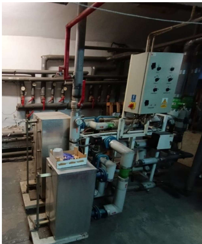
Widok na obiegi grzewcze (rozdzielacze) oraz aparaturę węzła ciepłowniczego.
