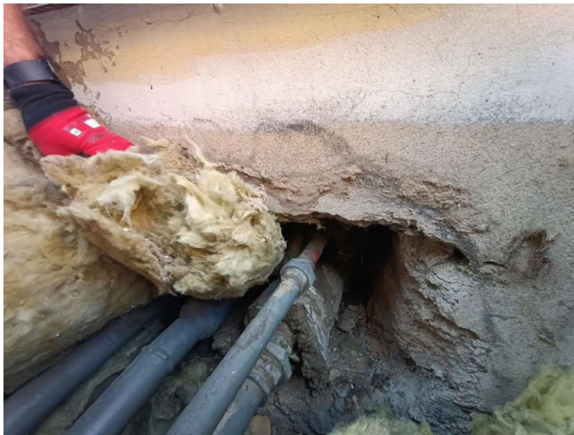
Widok na istniejące rury ciepłociągów.
